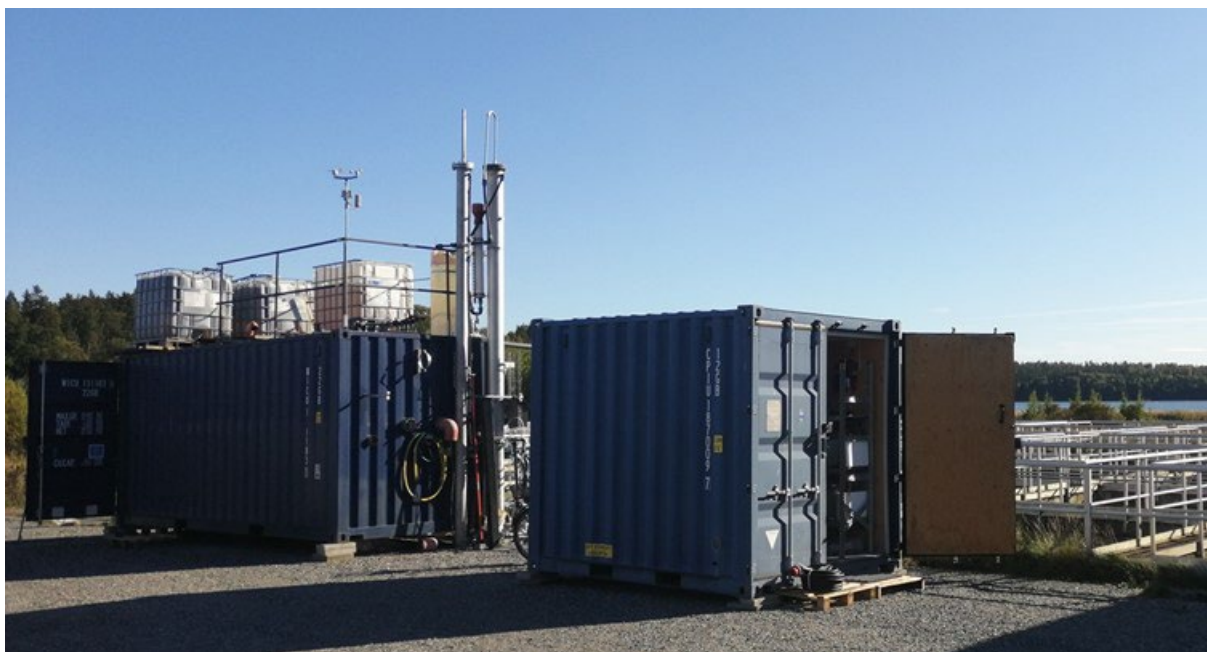
Figur 3.1.1: Pilotanläggningen med en 5 m hög ozonkontaktkolonn. Akvariecontainern för fisk- och snäckexponering till höger
