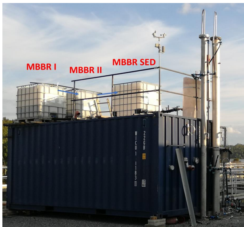
Figur 8. Pilotanläggningen med de tillbyggda nitrifikationsfiltren på taket (uppdateras).
