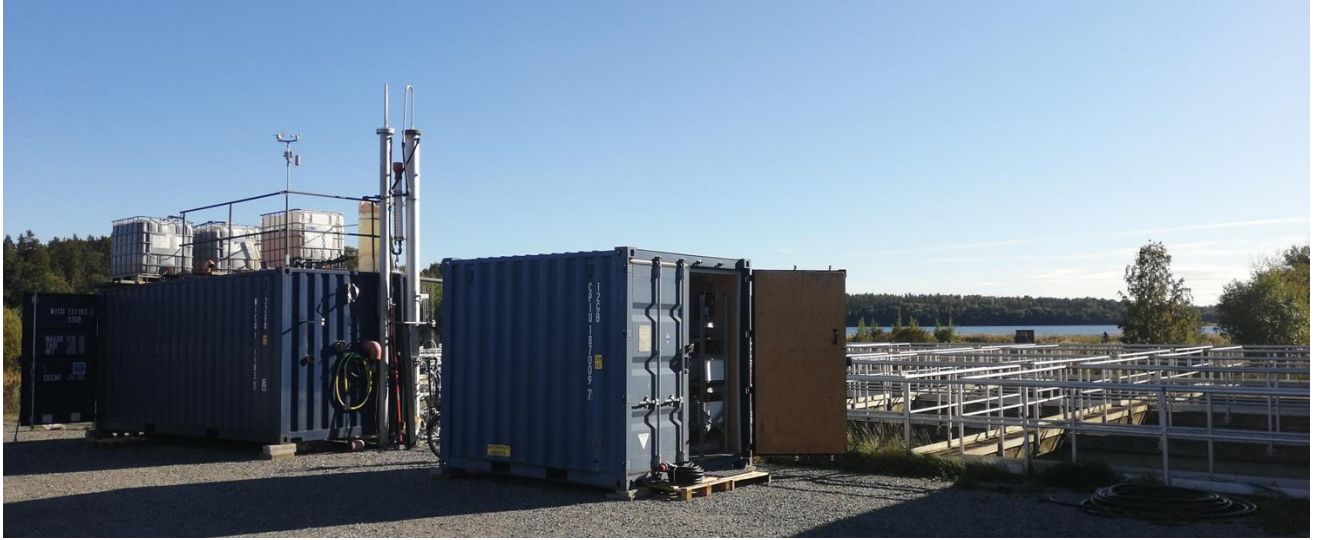
Figur 1. Pilotanläggningen med nitrifikationstankar på taket och 5 m höga ozonkontaktkolonner. Akvarie-containern för fiskexponering i förgrunden, eftersedimentering och Norrtäljeviken i bakgrunden.
