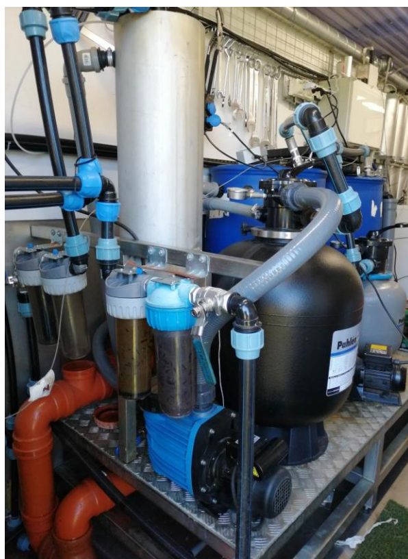
Figur 4. Förbehandling med grovfilter, förfilter och filtrattankar
