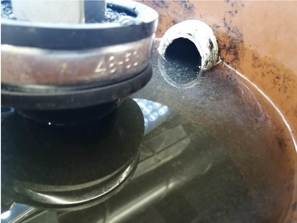
Figur 20. Backspolning av GAC-filtret – avskilda flockar spolas bort.
